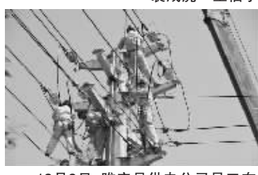
12月2日,睢宁县供电公司员工在零下10度的杆顶压接导线,加快10千伏线路改造工程施工进度,确保百姓能用上舒心电、放心电,抵御严寒的侵袭。 全勇 刘天让
