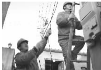
为保障居民在寒潮之际空调负荷增大情况下的可靠供电,高邮市供电公司组织人员对一些用电负荷较大的配电台区的低压接户线进行整改。 林华鹏 吴继明
