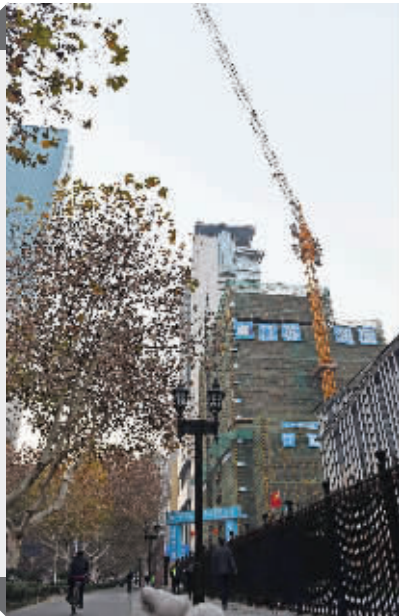
长江路,市民骑车从塔吊下经过
