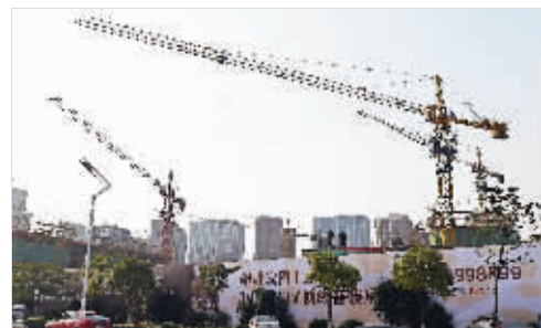
河西一处工地,塔吊臂伸到路上方
