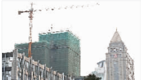
洪武路一处工地,塔吊臂悬在道路上空
