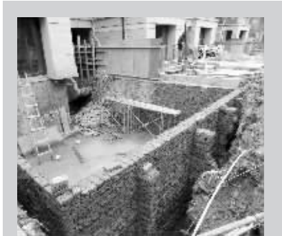
正在开挖的地下室
