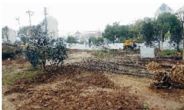
昨天记者看到，这个市民广场挖了很多树坑，准备移栽香樟
