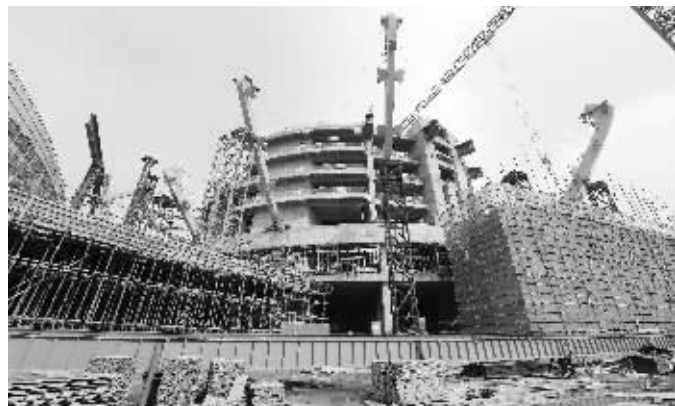
正在建造的江苏大剧院 现代快报记者 施向辉 摄
