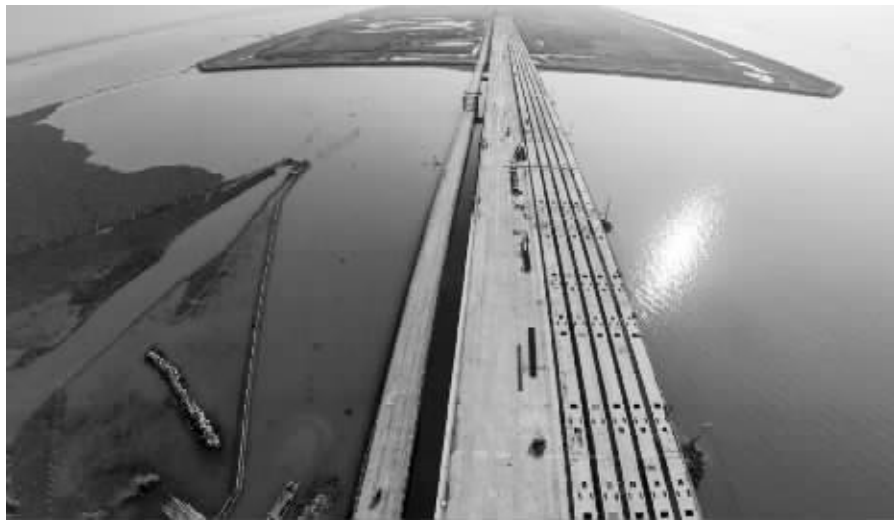
已经贯通的澄湖特大桥 苏州市高速公路建设指挥部供图
