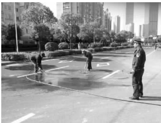
冲洗被污染的路面
