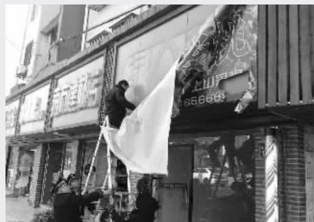
拆除破损广告 南长城管供图
