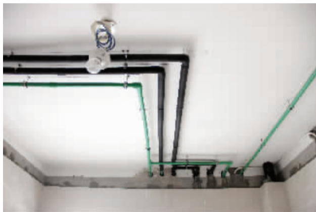
水管顶面排布、横平竖直，用吊筋固定，热水管及循环水管进行保温处理
