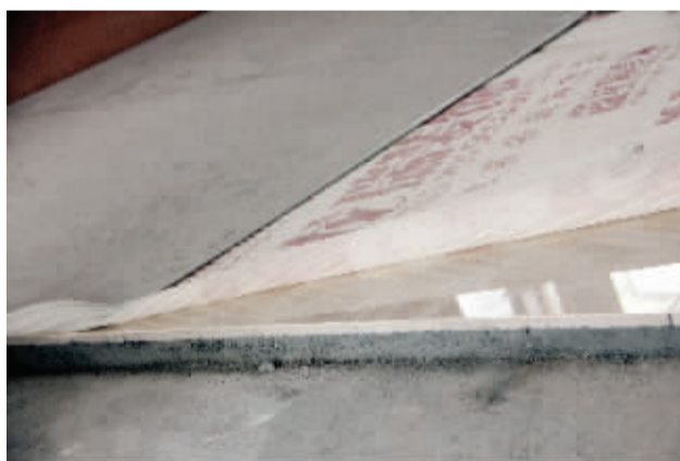
地砖铺贴好，用抹布擦拭干净后，先用保护膜进行铺贴，再覆一层水泥压力板，确保入住时无一划痕
