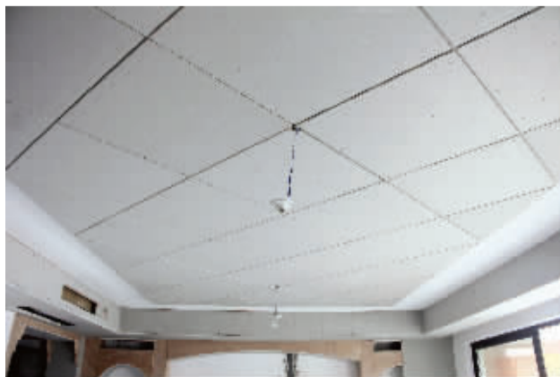
石膏板拼缝间必须开V形槽，确保油漆工艺面层不开裂
