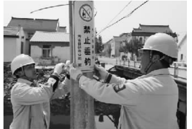
海安供电公司清理维护鱼塘警示牌
