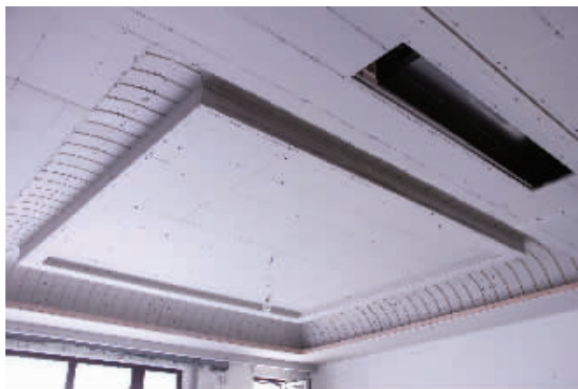
石膏板弹线固定，螺丝间距横向30cm，纵向20cm
