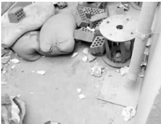
顶楼业主改造“公共阁楼”的施工材料 刘先生供图
