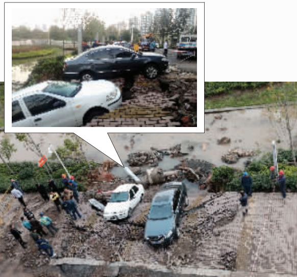
由于水管破裂,附近地面下陷,两辆轿车被困 现代快报记者 马晶晶 摄
