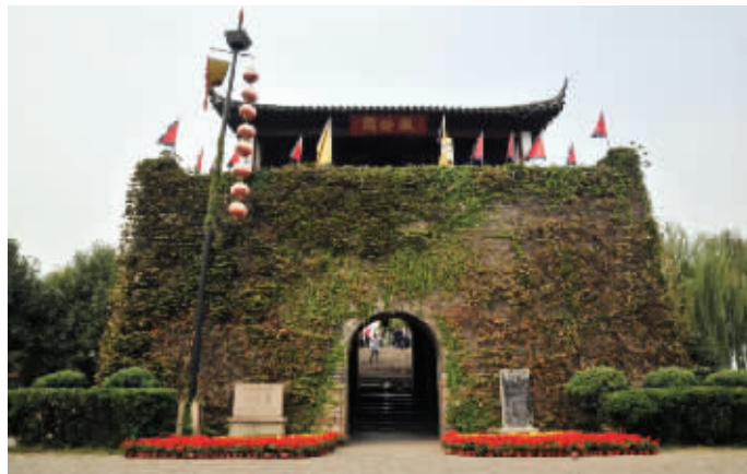
修缮后的铁铃关 枫桥景区供图
