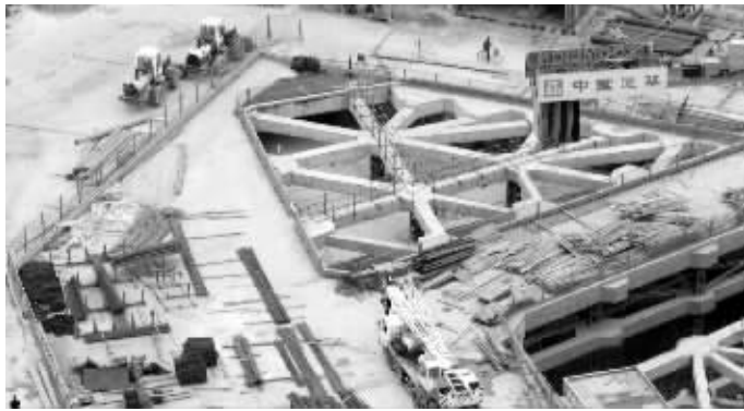
金融城施工现场 中建八局第三建设有限公司供图
