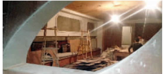
孟非的小面正在装修
