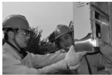
乡间公路照明亮化工程是今年高邮市政府的民心工程,该市14个供电所主动跟踪服务,及时为已安装好的338盏路灯装表接电。图为:施工现场
