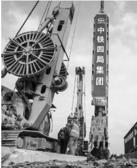
地铁1号线开工现场 陆文杰 摄
