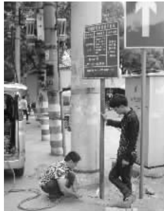
拆除过期、公示不明及违规设置的停车牌 城管供图
