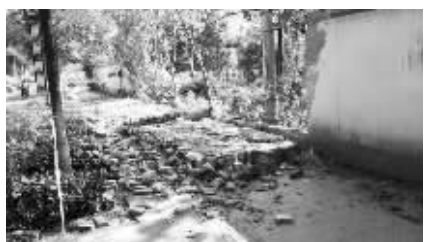
事发现场倒塌的围墙
