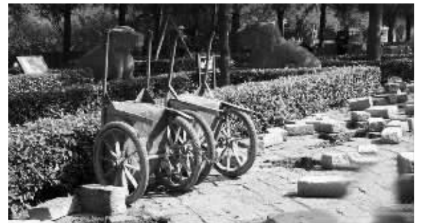
石象路这两天正在施工 报料人供图
