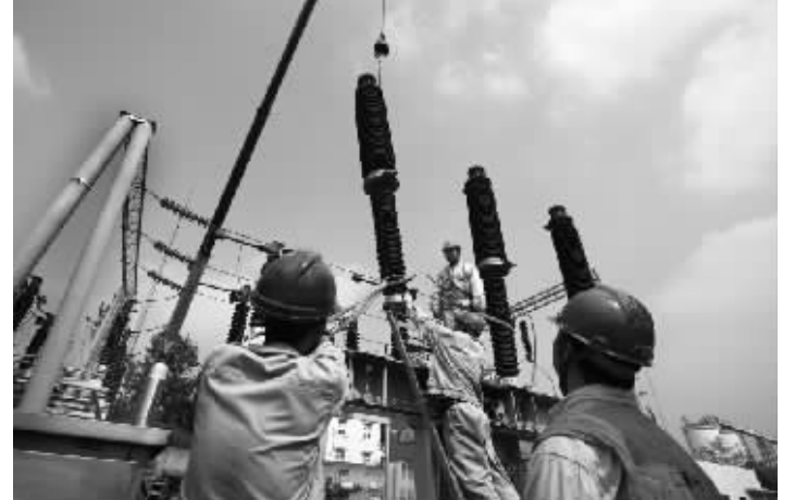
10月20日徐州110千伏大杏窝变电站技术改造工程如火如荼
