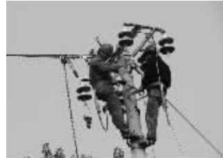
睢宁县供电公司抢抓秋收冬种的间隙,走进白茬地,加快农电线路改造。据统计,10月15日以来,该公司为龙集镇架设并改造10千伏线路2.6千米。
