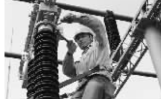
入秋以来,兴化供电公司组织开展以“保人身,除隐患,促提升”为主题的秋季安全大检查活动,全面消除设备安全隐患,确保设备安全度冬。
