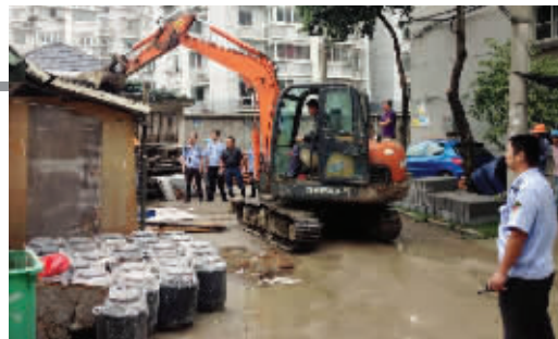
拆除水仙里小区违法建设
