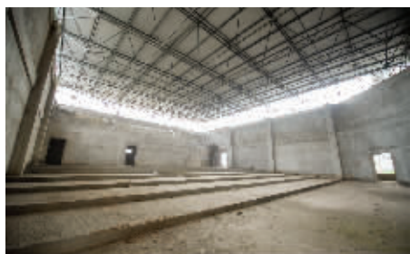
安徽萧县闲置“政府办公楼”内部
