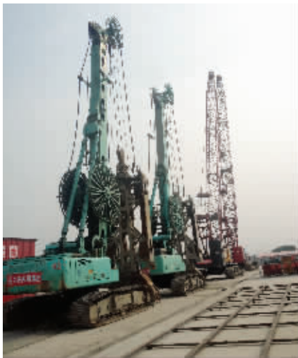
嫩江路施工现场大型机械已经进场
