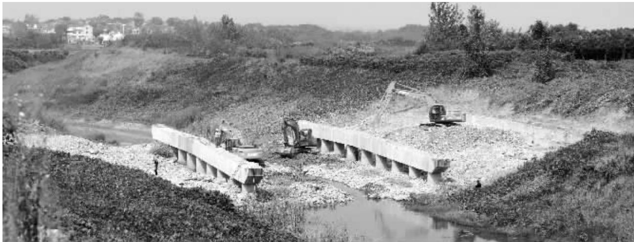
徒盖河上,这座新桥桥面已被拆除,只剩下桥墩 现代快报记者 马晶晶 摄
