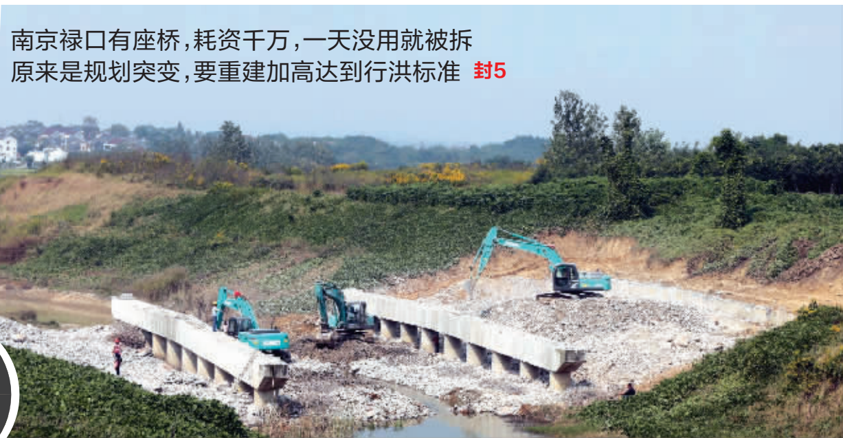
大桥桥面已被全部拆除 现代快报记者 马晶晶 摄
