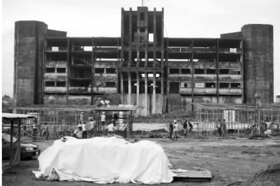
蒙罗维亚正在修建的隔离中心
