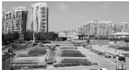
施工现场 现代快报记者 刘伟伟 摄
