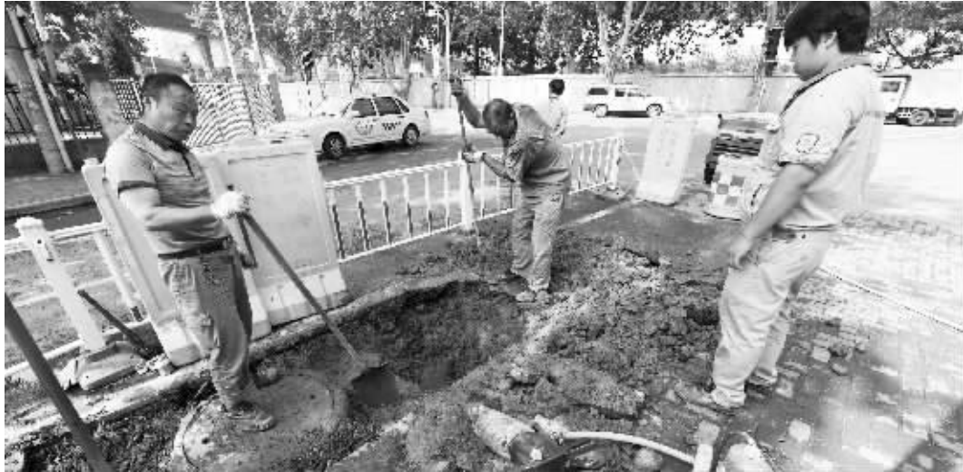
天然气管道检修 现代快报记者 邱稚真 摄
