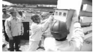
供电员工在比赛现场改造线路。
