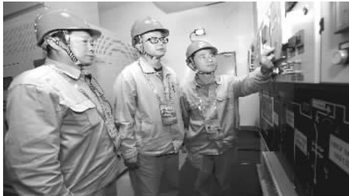
9月19日下午,徐州供电保电人员为确保省运会开幕式万无一失,再次检查设备。
