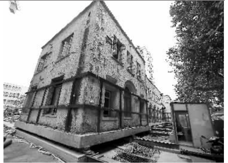
这幢民国建筑要整体平移37米 现代快报记者 顾炜 摄
