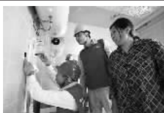
9月8日,姜堰供电公司国家电网江苏电力共产党员服务队的12名队员,对辖区内打工返乡家庭的用电设施和电线进行隐患排查和改造,确保外出务工人员返乡用电无忧。图为党员服务队队员在姜堰大伦镇东徐村村民家中更换热水器开关板。
