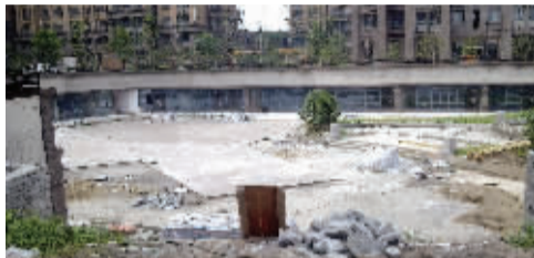
小区中央广场部位还是未完工地
