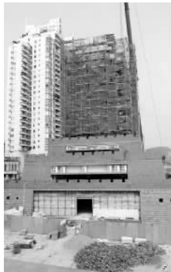
正在拆除的工地
