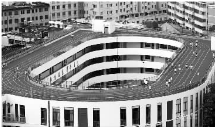
屋顶上的环形跑道
