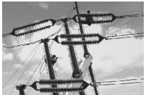
8月25日,泰州供电冒着高温对220千伏洋思变丹天变双回路线路进行改造,以提升对泰兴市丹天化工企业的供电能力。贾家平 陈家明
