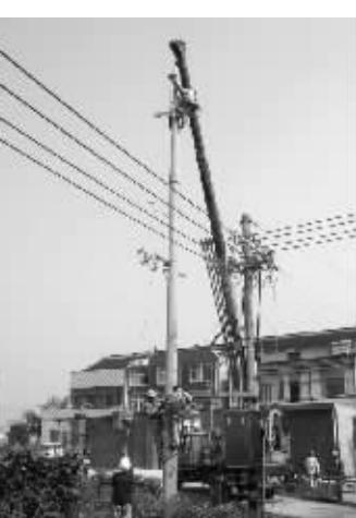
图为8月5日，泰兴市供电公司施工人员在该市大生镇迎幸村10千伏农西121线施工现场进行增容改造作业，满足该镇客户用电需求。肖杰文
