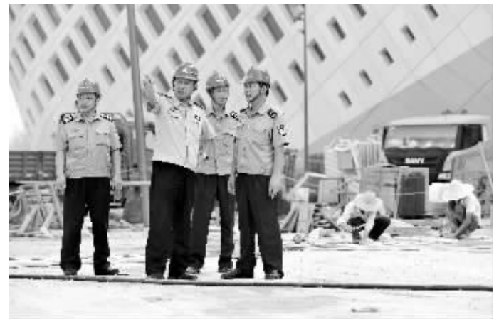
桂世荣(左二)带着保安在工地检查安全情况 通讯员供图
