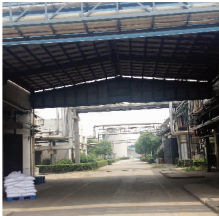
搭建的雨棚存在安全隐患 葛小林 摄
