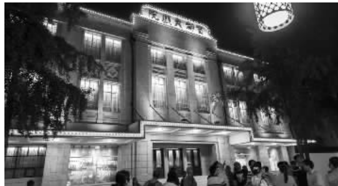
首都大戏院外立面修缮完毕 图片来自网络
