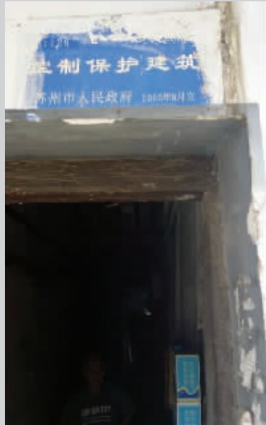
门框上面有“控制保护建筑”的牌子
