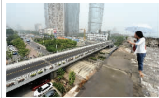
玄武门城墙段附近新建的高架桥
