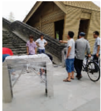
即将安装的闸机 网友供图
