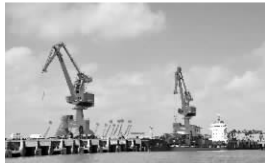
已经投运的海门港5万吨级码头 海门宣传部供图
