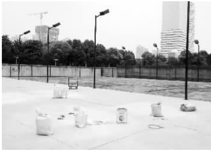
武进国土分局建造的球场,水泥地面已经浇好 刘国庆 摄
