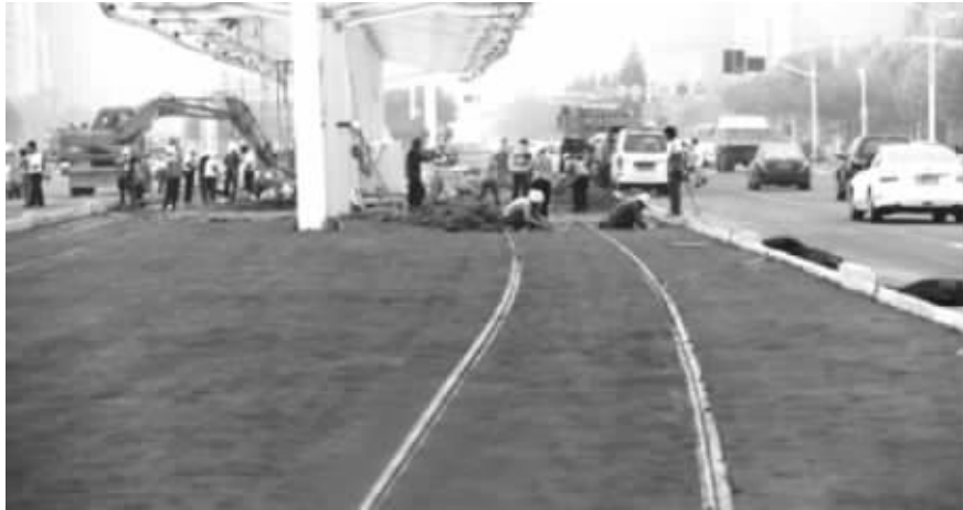
河西有轨电车轨道上正在铺设草皮 图片来自南京发布
