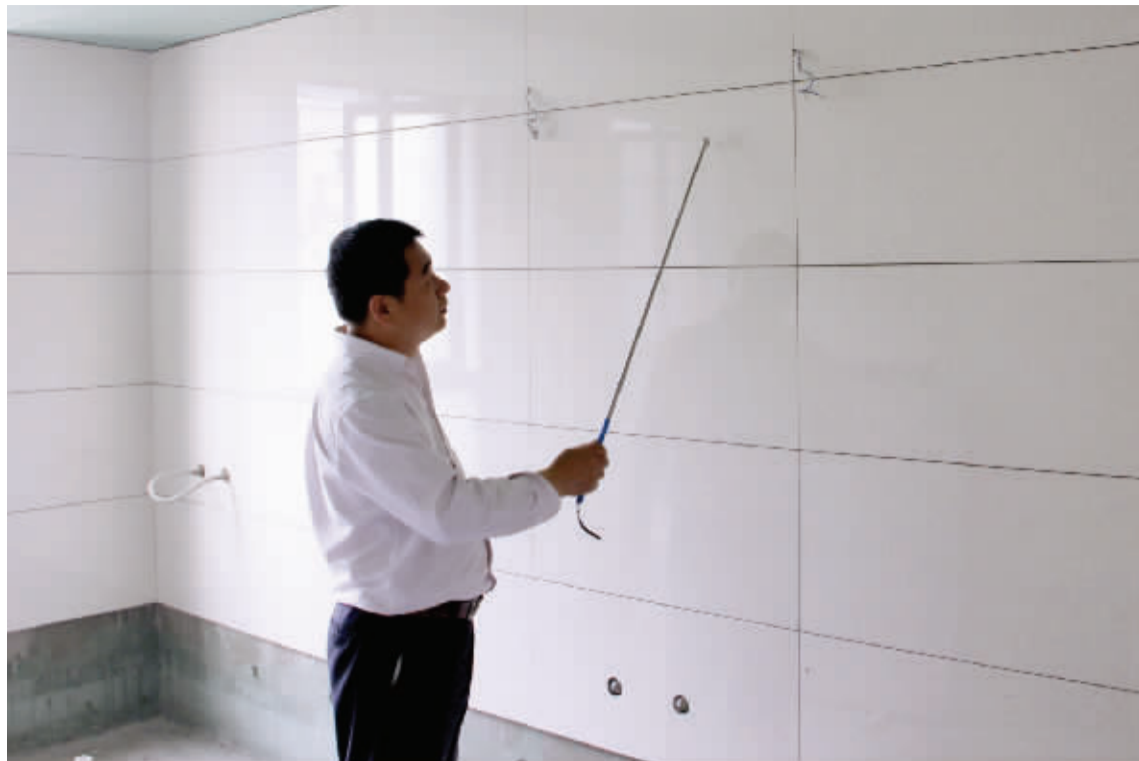
龙瑞装饰质检经理在对瓷砖铺贴的空鼓率和平整度进行检查
