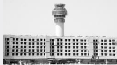
禄口机场二期新塔台 江苏空管分局供图
