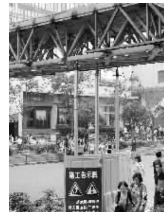
今年1月3日临时封闭的洪武路过街天桥,于本月初开始原地加固。昨天凌晨,有市民经过天桥时发现,夜间维修工作已经启动。现代快报记者从相关部门获悉,天桥维修将于7月初结束,目前正在进行钢构件的更新、加固,过几天将在现场搭建脚手架。
