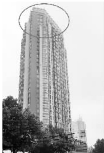
楼顶违建 现代快报记者 邱稚真 摄
